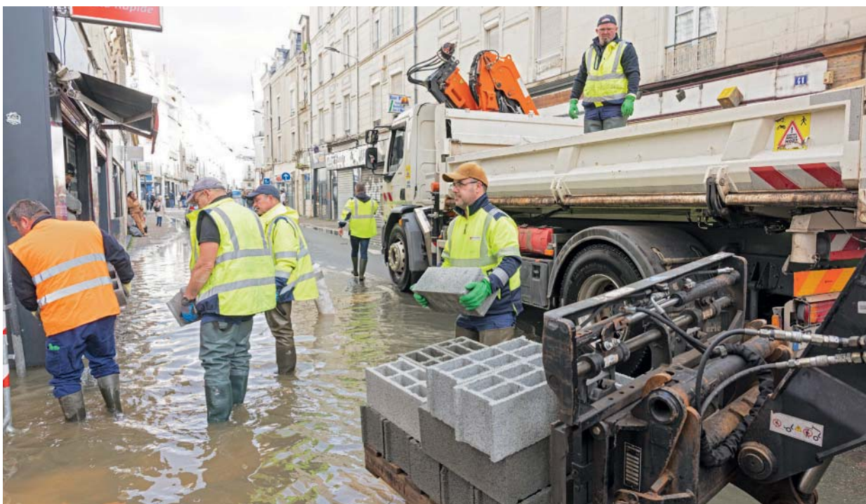
À Angers, les agents de la Ville installent parpaings et planches en bois dans les zones sinistrées, comme ici rue Parcheminerie.
