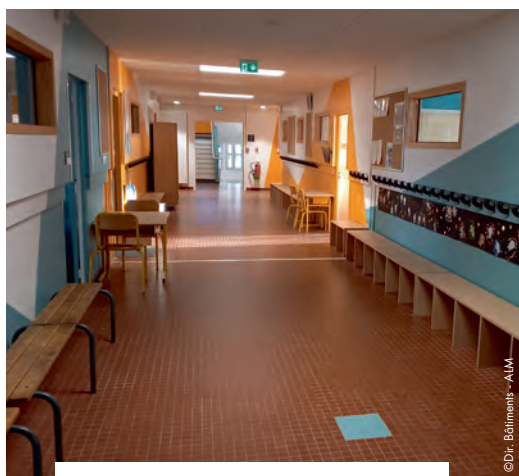
Conservation du carrelage existant lors de la restructuration du groupe scolaire Voltaire à Angers. © Dir. Bâtiments - ALM
