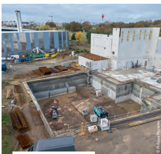
Construction de la nouvelle chaufferie Mayenne 2.
