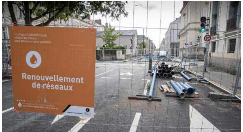
Figure 39. Opération de renouvellement de réseau. (Source : Ville d'Angers)
