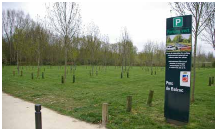
Figure 20. Aménagement d'une zone en parking drainant dans le parc Balzac à Angers (Source : ALM)
