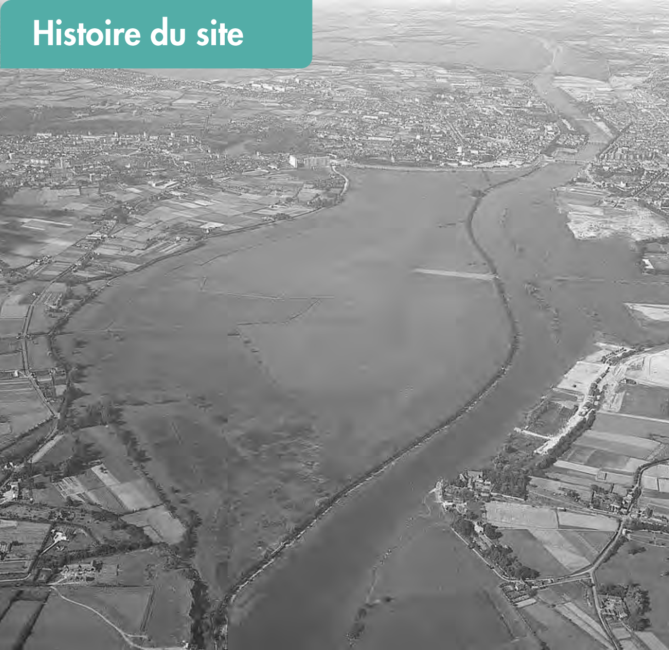
Les prairies d'Aloyeau et de bord de Maine, à l'emplacement du futur lac de Maine, vue aérienne, juin 1966. Photothèque Ville d'Angers
