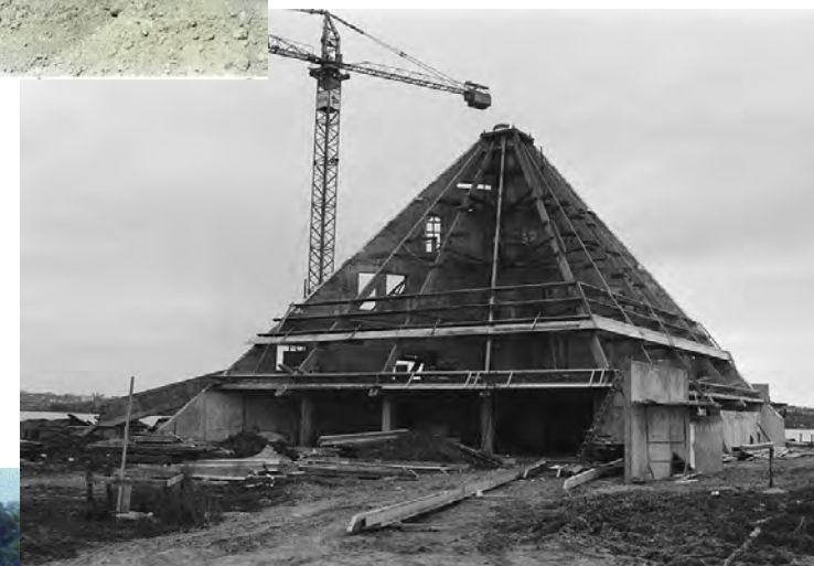
Le Centre nautique en construction, 1977. Photothèque Ville d'Angers.
