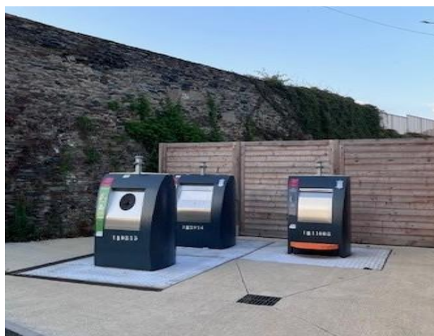
Intégration de conteneurs enterrés
