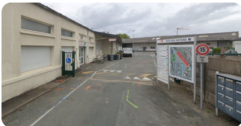
Bâtiment rue des Noyers
