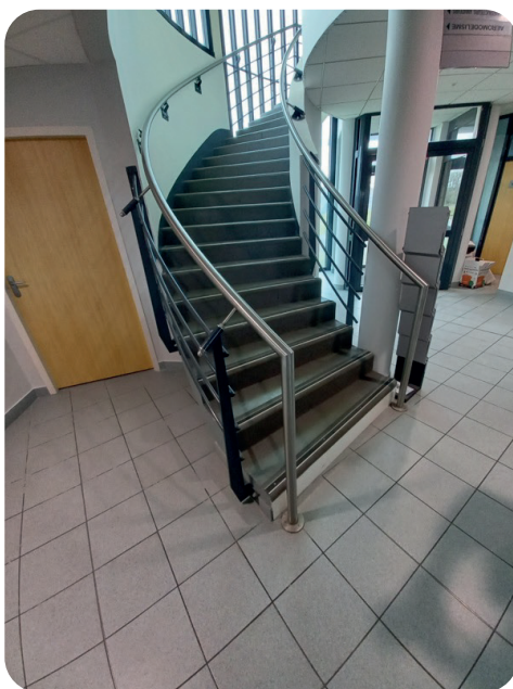
Main courante de l'escalier de l'aérogare
