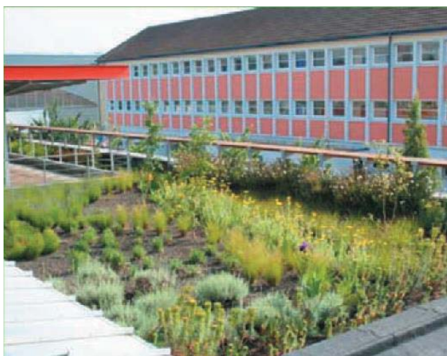
Toiture stockante végétalisée
