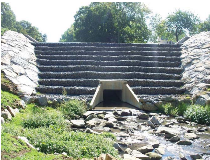
Déversoir d'orage en Gabions de forme escalier
