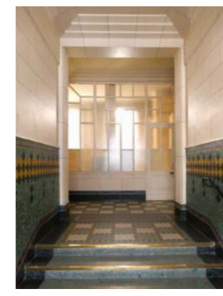
Prolongement des décors de mosaïque des sols jusqu'aux cimaises des murs, dans les vestibules et cages d'escalier.
