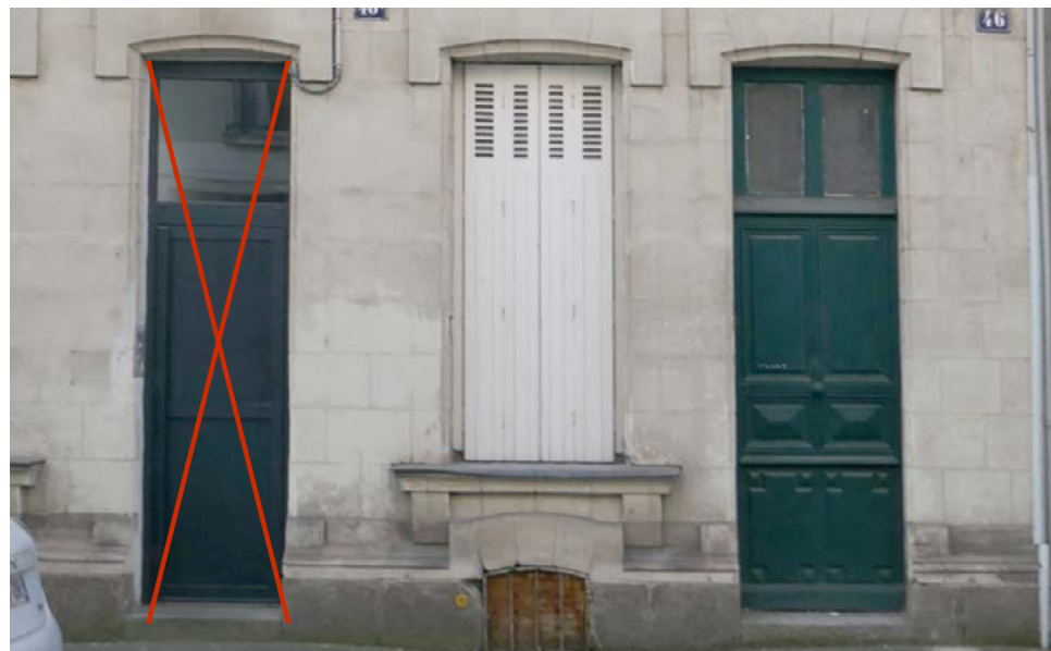
Porte métallique neuve
