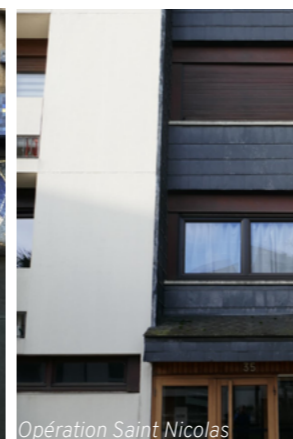
Opération Saint Nicolas Immeuble d'habitation Saint-Nicolas : béton peint, habillage d'ardoise et bardage bois.
