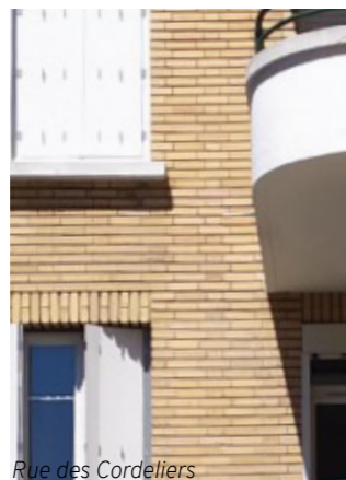
Rue des Cordeliers ↑ Immeuble d'habitation, ↓ Ancienne usine Cointreau.
