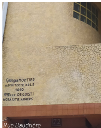
Rue Baudrière Immeuble d'habitation 1940 Pose en opus incertum (contours irréguliers)
