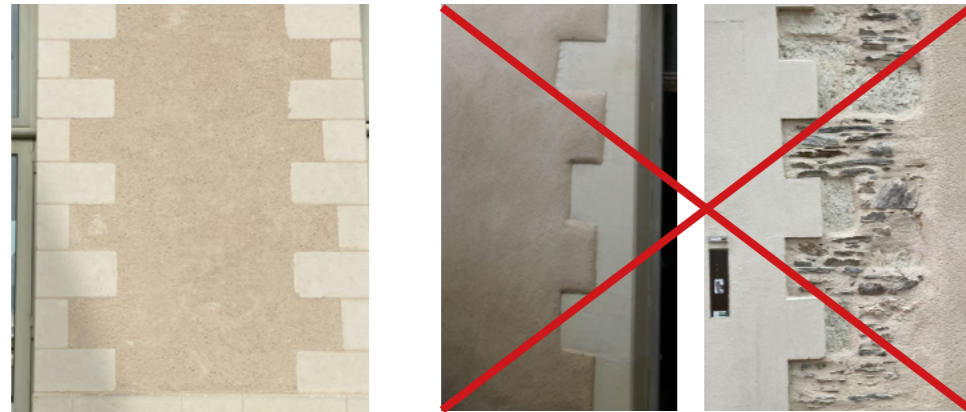
✓ Enduit affleurant à l'encadrement de baie
