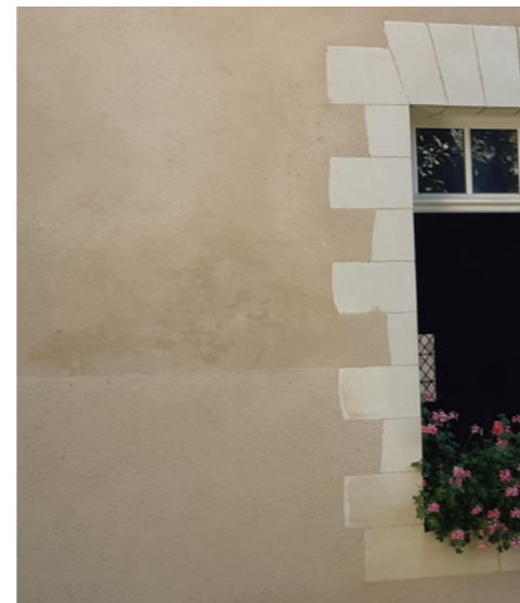
Enduit traditionnel en bon état
