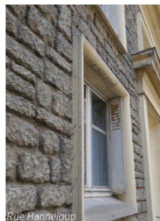
Rue Hanneloup ↑ Habitation individuelle 1938 ↓ Immeuble d'habitation
