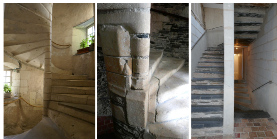
Escalier en vis en tuffeau
