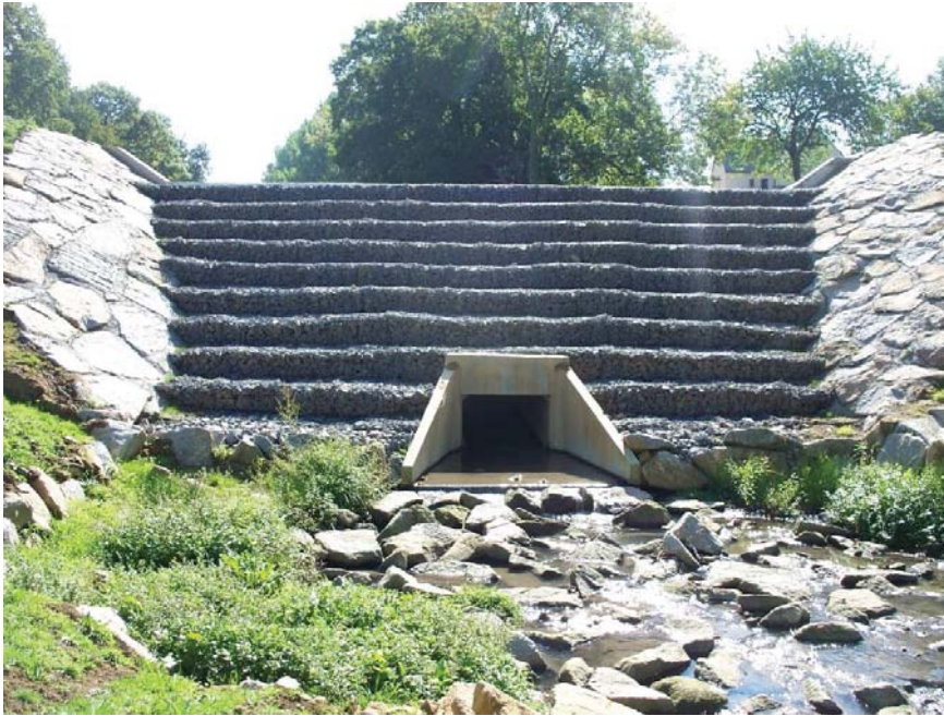
Déversoir d'orage en Gabions de forme escalier
