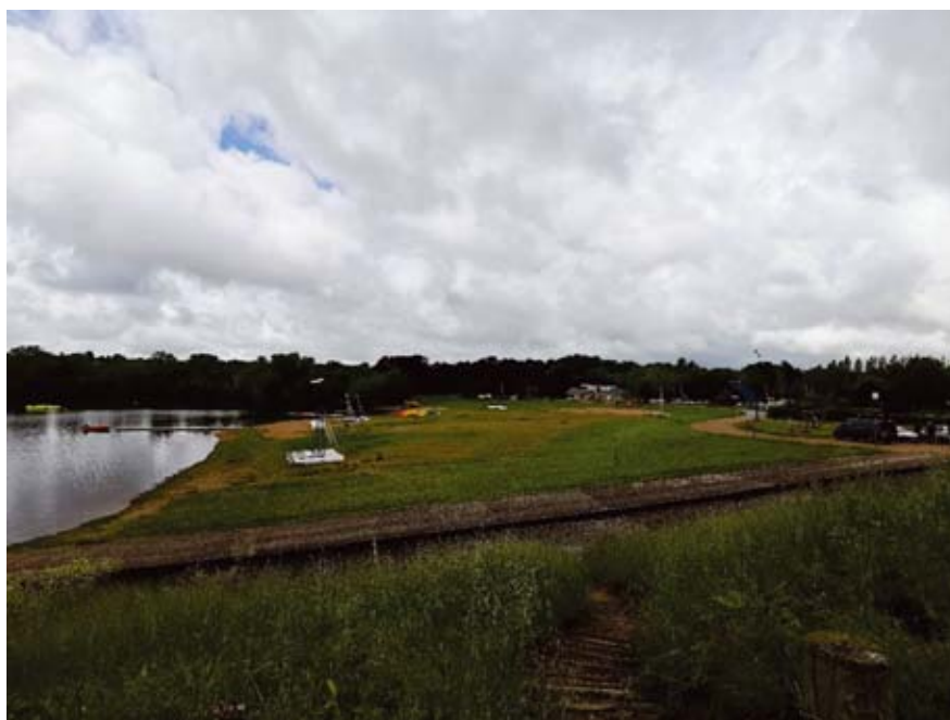
Figure 97 : Vue de la plage nautique
