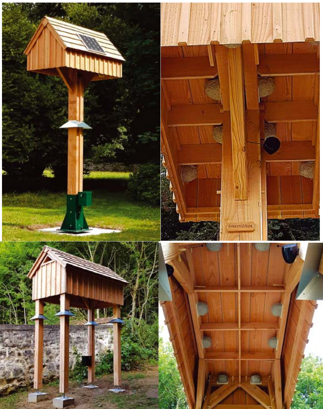
Figure 122 : Exemples de modèles de tour à Hirondelle rustique avec repasses sur panneau solaire et cônes anti-prédateur © Biosymbiose.
