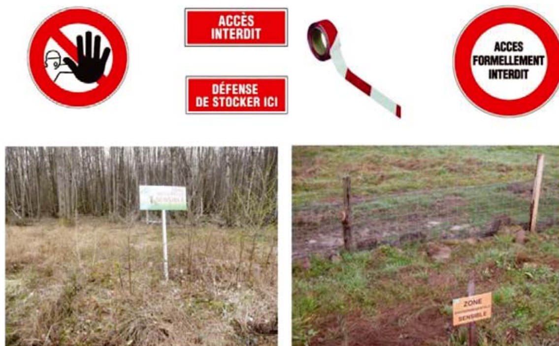
Figure 121 : Exemple de mise en défens et panneautage de zones à préserver en phase de chantier
