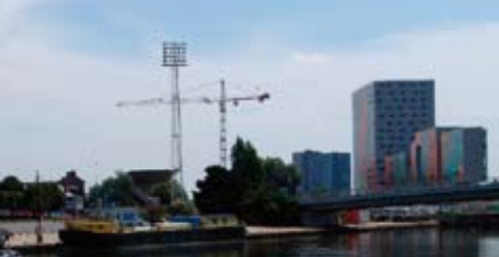
La requalification complète du stade Marcel Saupin suit son cours (à droite sur l'image). Le groupe Vinci investira notamment le complexe multifonctionnel sur près de 6 000 m² en février 2010.
