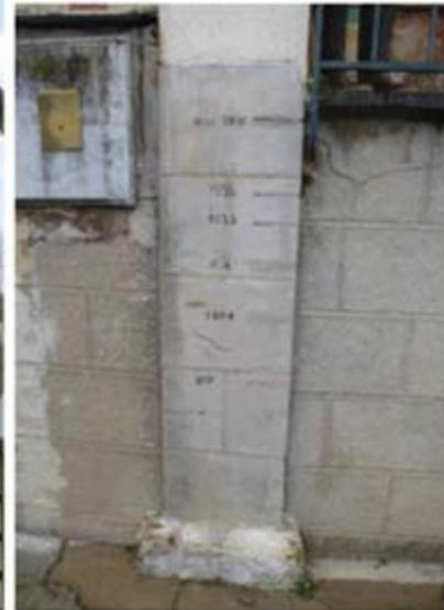
Exemple de « d'ouvrages hydrauliques et repères de crues »
