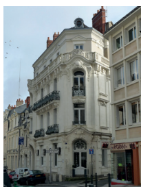
Immeuble baroque 15 rue St Martin Angers
