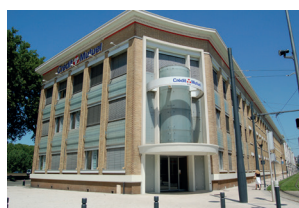
Ancienne Usine des Luisettes Angers
