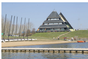
Centre nautique Angers
