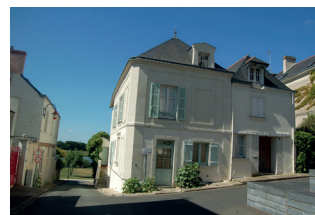
Rue du Port Ecoflant
