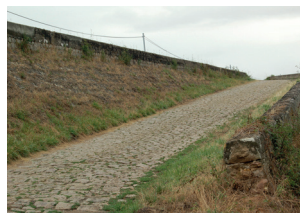
Loire-Authion Saint-Mathurin-sur-Loire rampe d'accès
