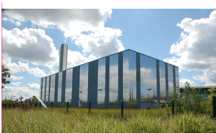
Chaufferie à bois, plateau Mayenne, Angers
