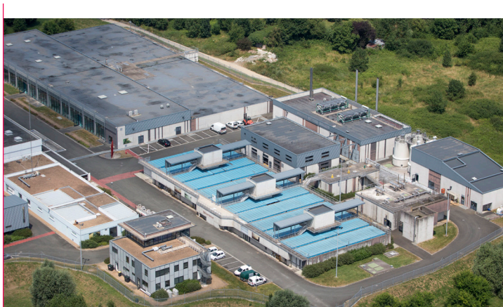
Usine de traitement d'eau potable, Les Ponts-de-Cé
