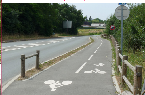
Aménagement cyclable, Ecoflant
