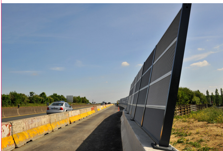
Protections acoustiques le long de l'A87, Angers
