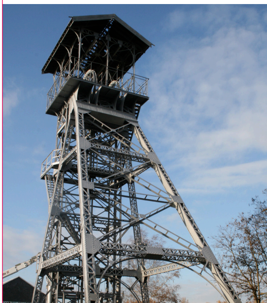
Puits Eiffel : les Ardoisières, Trélazé
