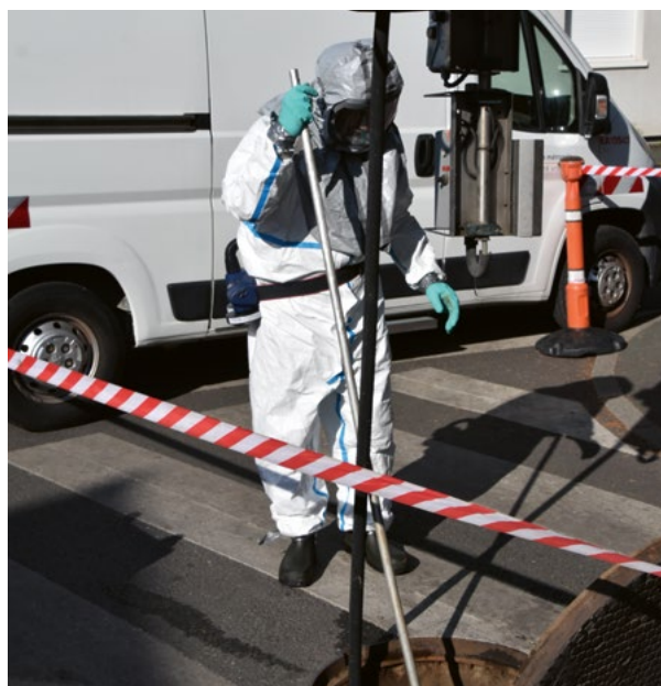
Intervention curage avec protocole amiante
