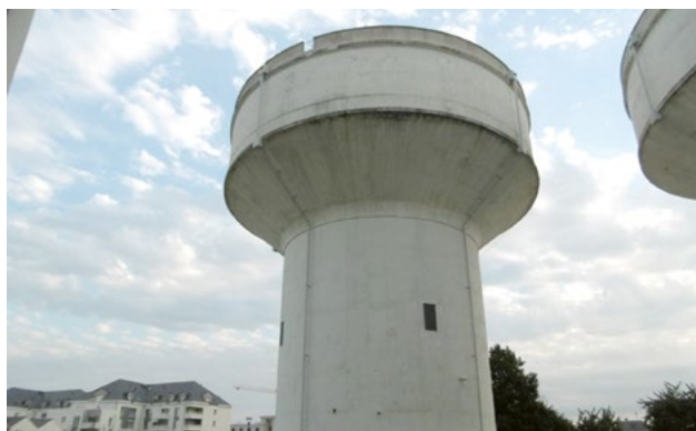
Réservoirs sur tour de Berry
