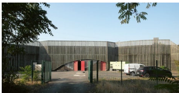
Réservoirs semi-enterrés de La Belière
