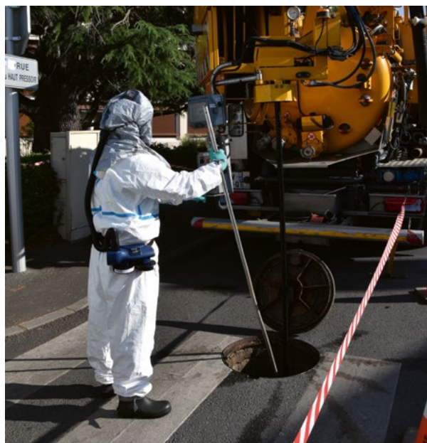
Intervention curage avec protocole amiante
