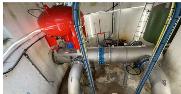
Renouvellement du pompage de secours d'eau brute à l'usine de production d'eau potable
