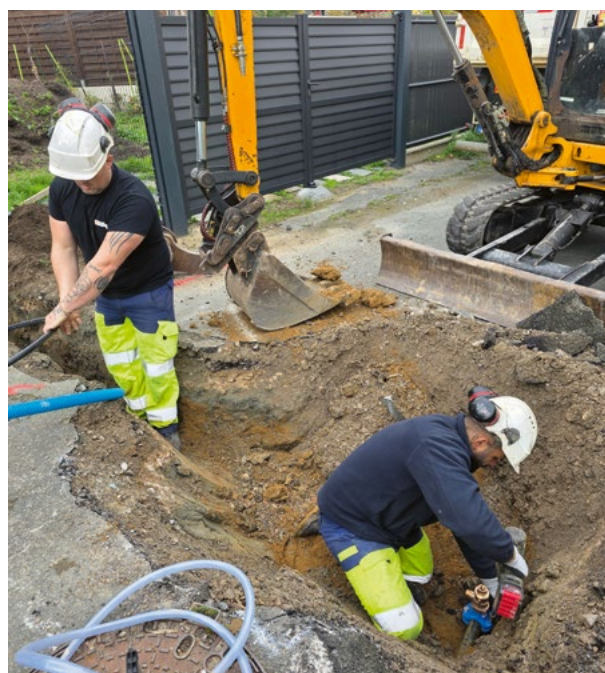
Chantier de création d'un branchement
