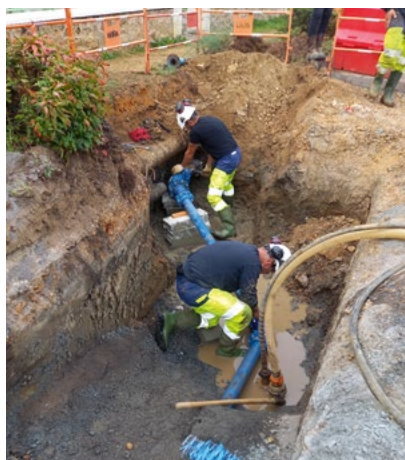
Raccordement de canalisation
