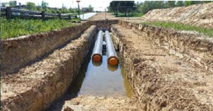
Travaux réseaux de chaleur, préparation de la traversée de l'Océane, 180 mètres de forage à 22 mètres de profondeur
