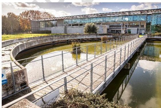
Usine de production et de traitement des eaux des Ponts-de-Cé – Crédit Photo : Ville d'Angers, Th. Bonnet
