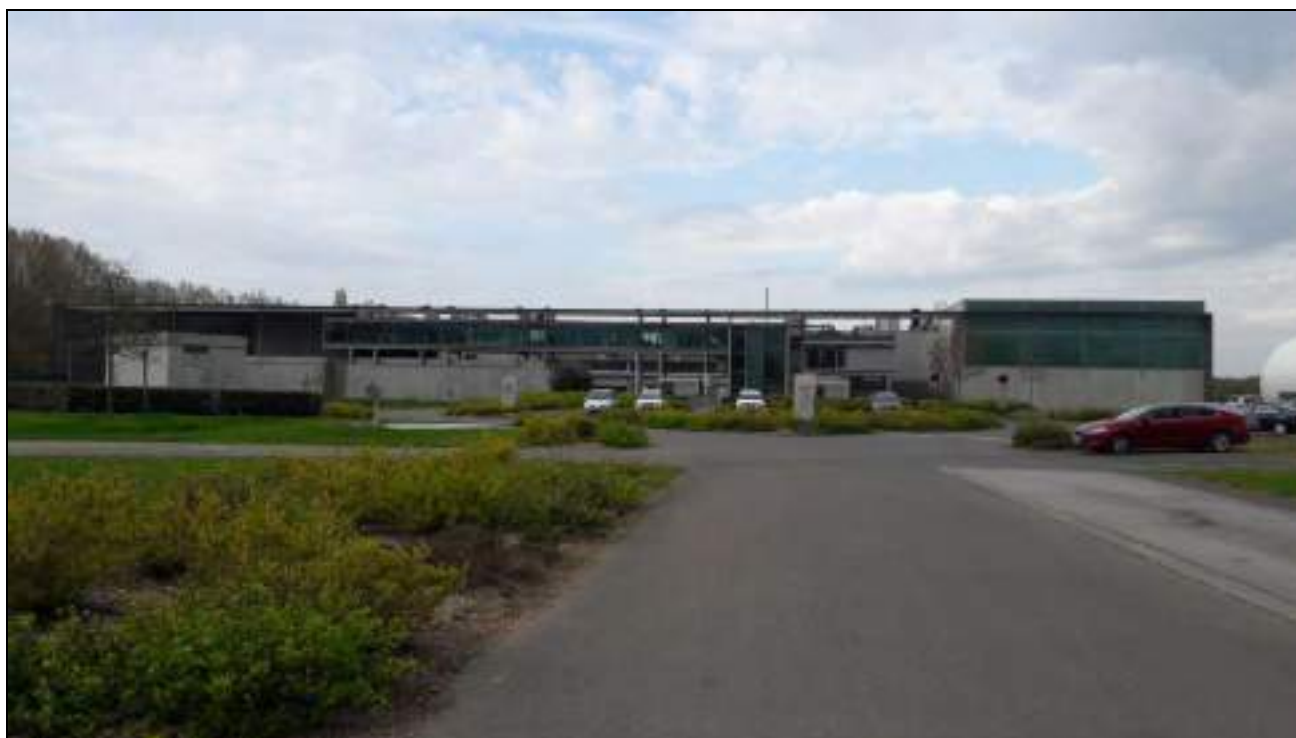
Figure 10 : Vue sur l'accès au site de la STEP et de la centrale au sol
