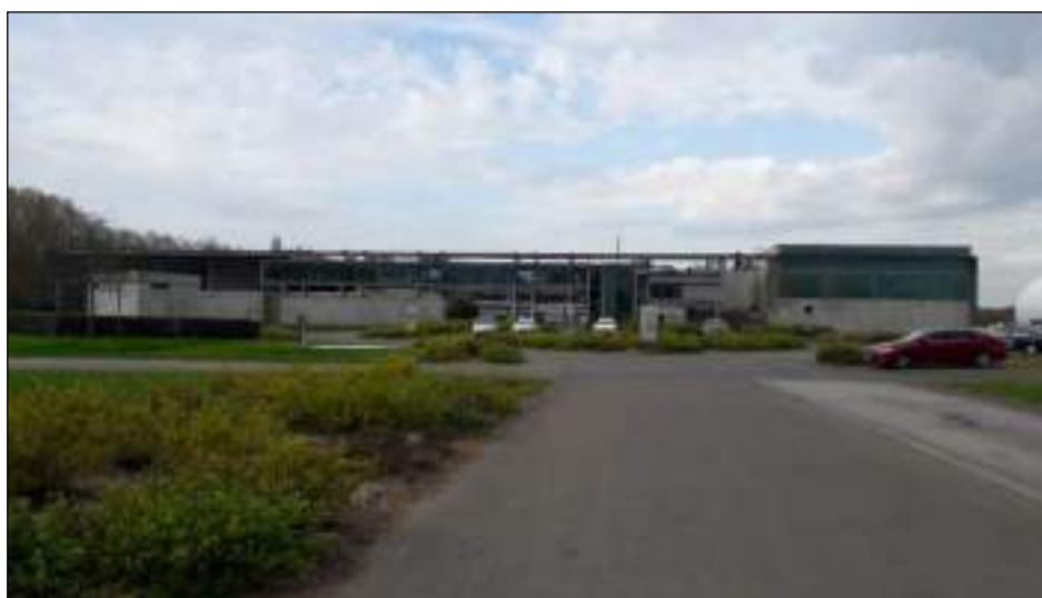
Figure 18 : Vue sur l'accès au site de la STEP et de la centrale au sol
