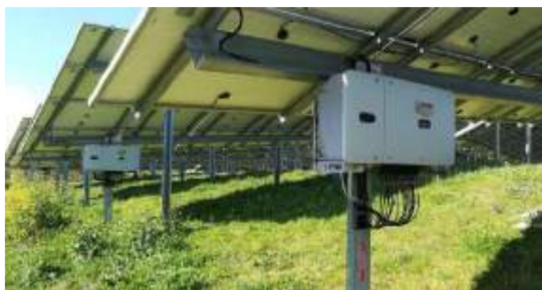
Figure 7 : Choix technique d'implantation des onduleurs
