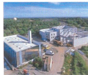
Construction de la nouvelle chaufferie Mayenne 2
