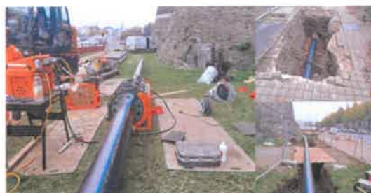
Tubage de la conduite de distribution – Avenue de Gaulle – Angers
