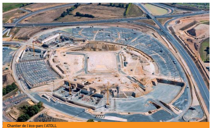
Chantier de l'éco-parc l'ATOLL
