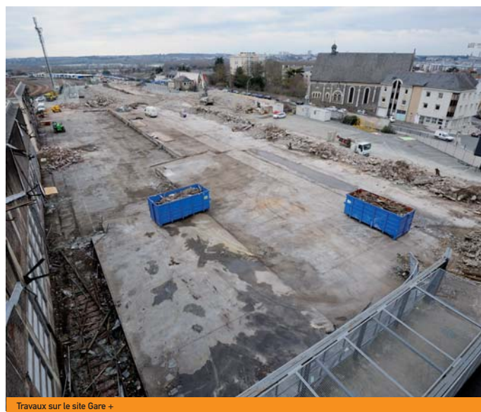
Travaux sur le site Gare +
