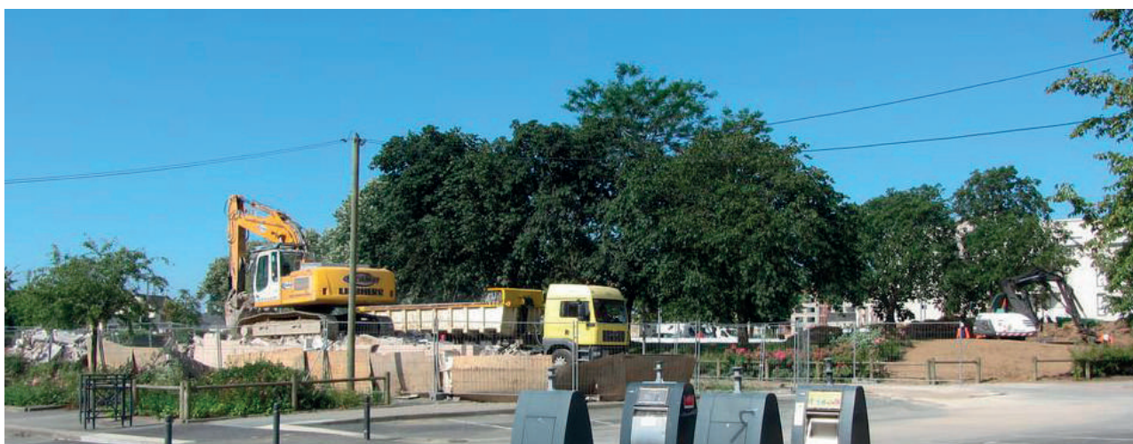
Démolitions en cours (Verneau)
