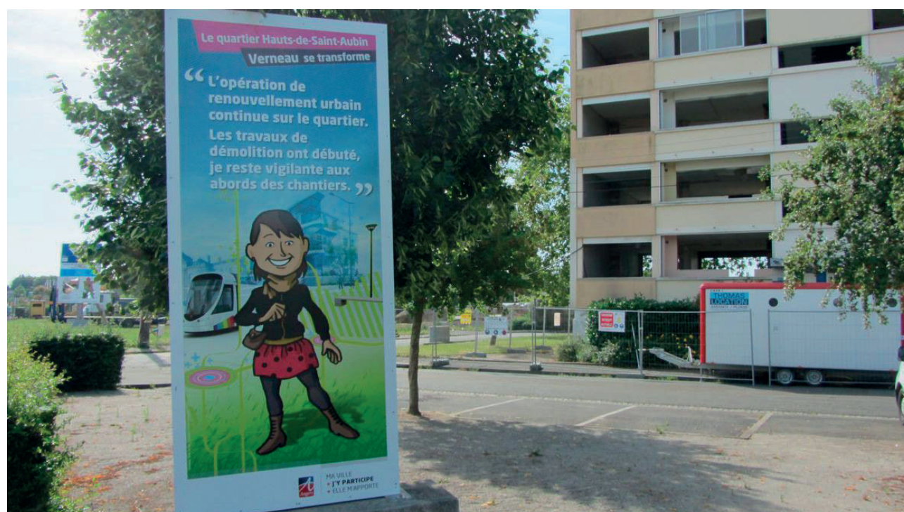
Information pendant les travaux (Verneau)
