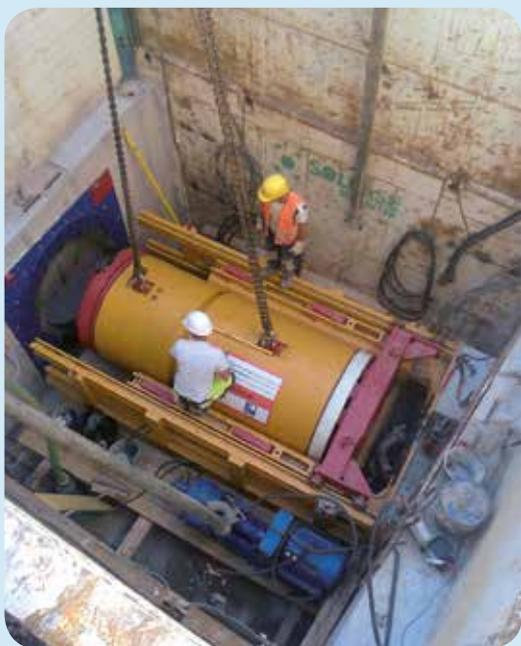
**Pour sécuriser le transfert des effluents vers la station de dépollution de la Baumette en rive gauche de la Maine, Angers Loire Métropole a procédé à la mise en place d'un nouveau collecteur en PRV de diamètre 1200 mm implanté entre les voies sur berges et le château. Les travaux ont consistés en la création d'un dessableur, et la pose de canalisations à la fois en tranchées ouvertes et à l'aide d'un micro tunnelier. Ces travaux d'un montant de 1.4 M€ HT ont duré 5 mois.**
