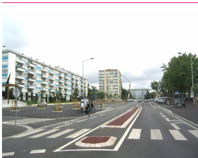
Boulevard Allonneau requalifié
