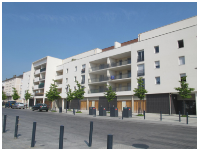
Opération privée - Place Picasso. Logements et locaux d'activités en rez-de-chaussée
