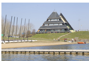
Centre nautique Angers
