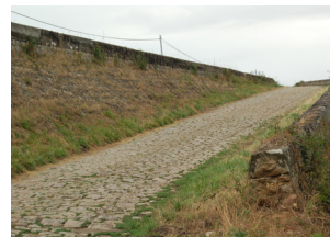
Loire-Authion Saint-Mathurin-sur-Loire rampe d'accès
