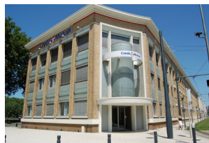
Ancienne Usine des Luisettes Angers
