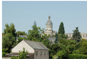
Couvent des Servantes des Pauvres 49 rue Parmentier Angers
