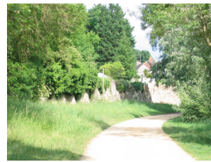
Mur d'enceinte du Château du Plessis-Macé
