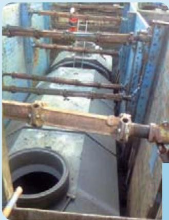
Pour réduire les délais de mise en œuvre et limiter le coût d'investissement, le bassin tampon de la station de refoulement de la Porée à Trélazé a été réalisé à partir de conduites de type Moduloval.
